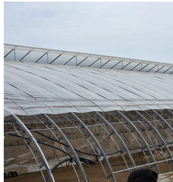
Seră din folie cu aerisire la coamă
